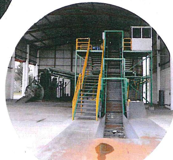
Figura 13. Resaca San Felipe y estación de transferencia, tratamiento y compactación de residuos. Fuente: Elaboración propia.
